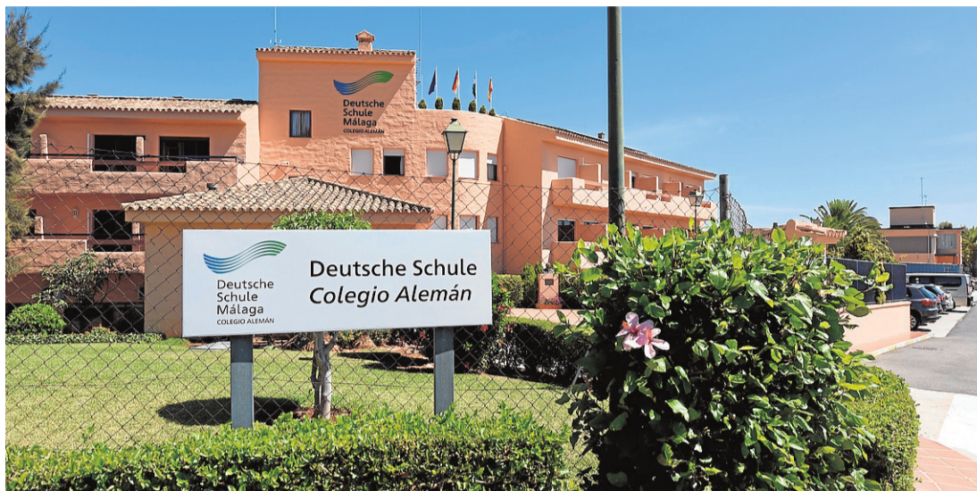
Die Namensänderung ist bereits sichtbar, innen gehen die Umbauarbeiten weiter. :: DEUTSCHE SCHULE
